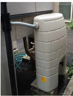
江川秀生宅設置の雨水タンクタキロン「雨音くん」150
