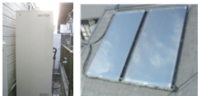
4年前に江川次郎宅に設置した【ノーリツソーラーシステム・太陽熱温水器 スカイピア強制循環タイプ UFJ】写真右側が集熱パネル。左側が蓄熱槽。
